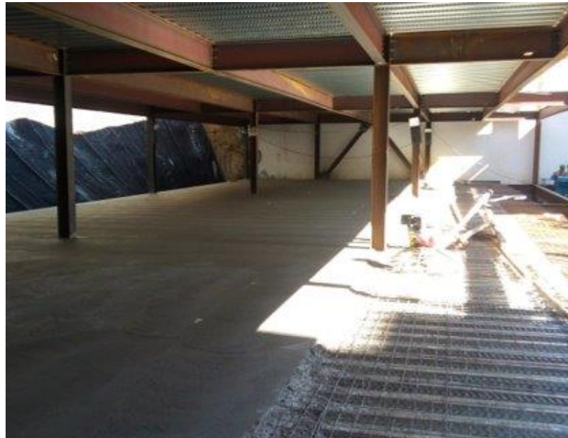
Figura 2: Piso misto - Fase de construção. Fonte: Visual Estruturas Metálicas (2022)
