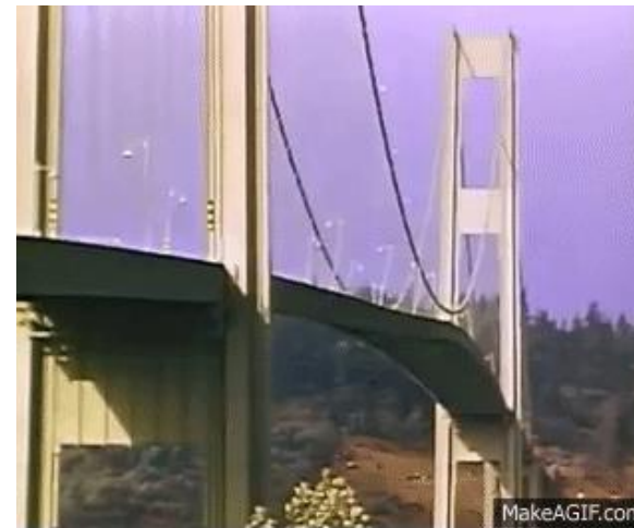
Estrutura experimentando o fenômeno de ressonância
