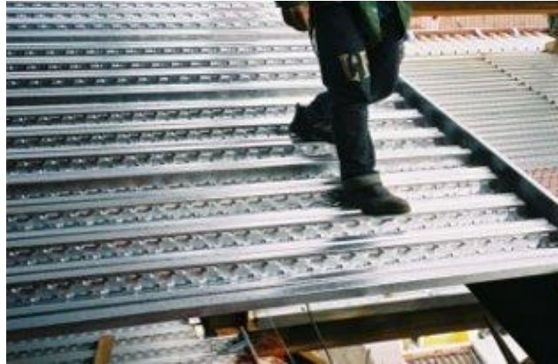
Figura 1: Steel Deck na fase de construção. Fonte: Favarato (2021a)
