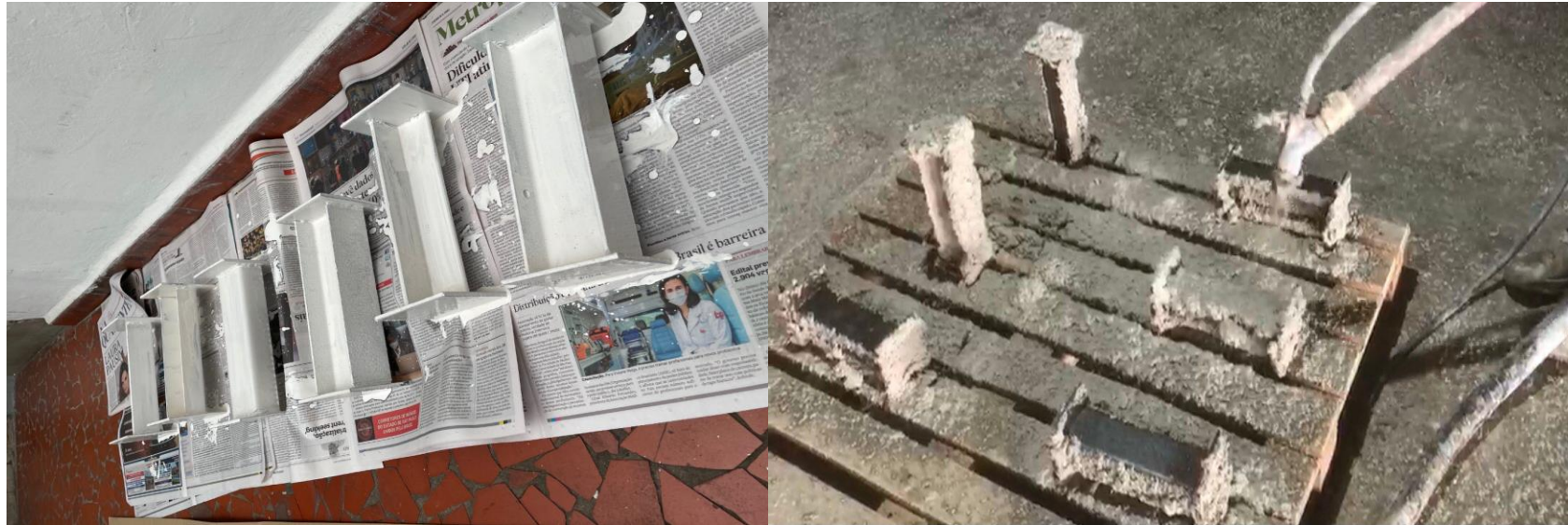
Figura 4 - Aplicação de tinta intumescente e argamassa projetada
