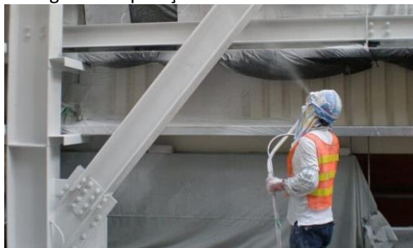
Figura 7 - Aplicação de tinta intumescente
