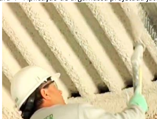
Figura 4 - Aplicação de argamassa projetada jateada
