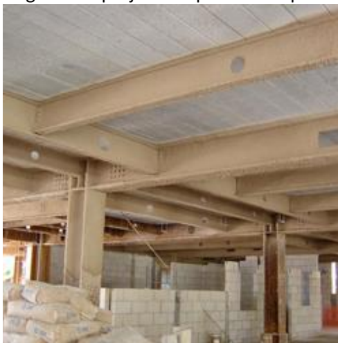
Figura 5 - Argamassa projetada aplicada em perfis metálicos
