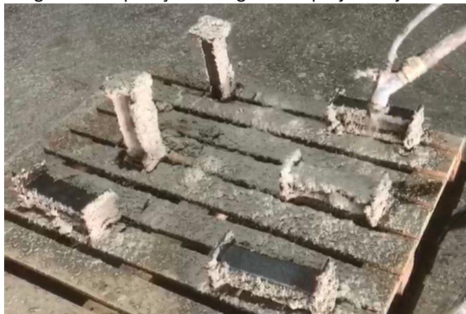
Figura 12 - Aplicação da argamassa projetada jateada
