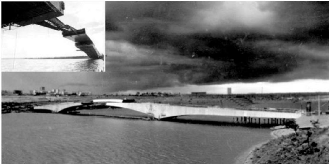
Figura 3 - Implantação do tabuleiro metálico. [3]
