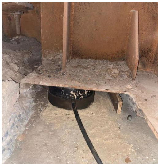
Figura 21 - Detalhe de um dos aparelhos de apoio na ponte. Fonte: Autores.
