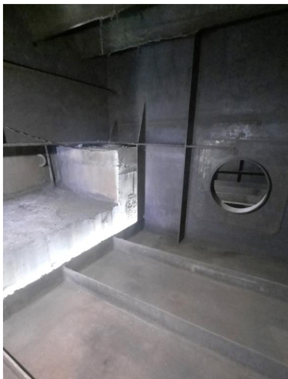
Figura 5 - Fotografia no interior do caixão na região do apoio. Fonte: Autores.
