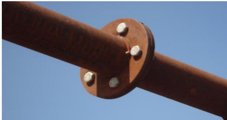
Figura 1: Ligação Flangeada
