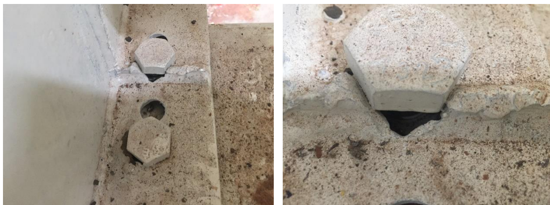
Figura 04 – Falta de linearidade entre furações com corte de enrijecedor e alargamento de furação - 02
