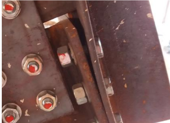
Figura 10 – Tentativa de ajuste de ligação através do aperto excessivo de parafusos
