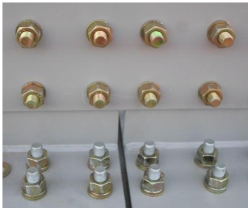
Figura 21 – Mistura de parafusos e porcas com especificações diferentes
