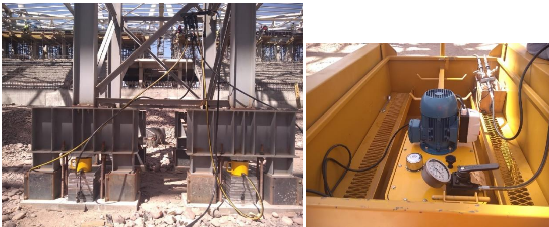
Figura 24. Base de las torres de apeo (izq.) equipo de bombeo (der.)
