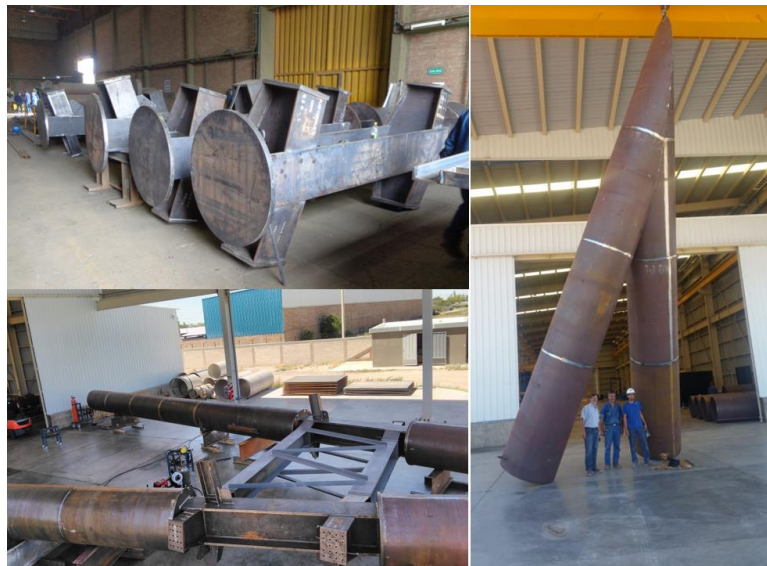
Figura 15. Fabricación de columnas en A
