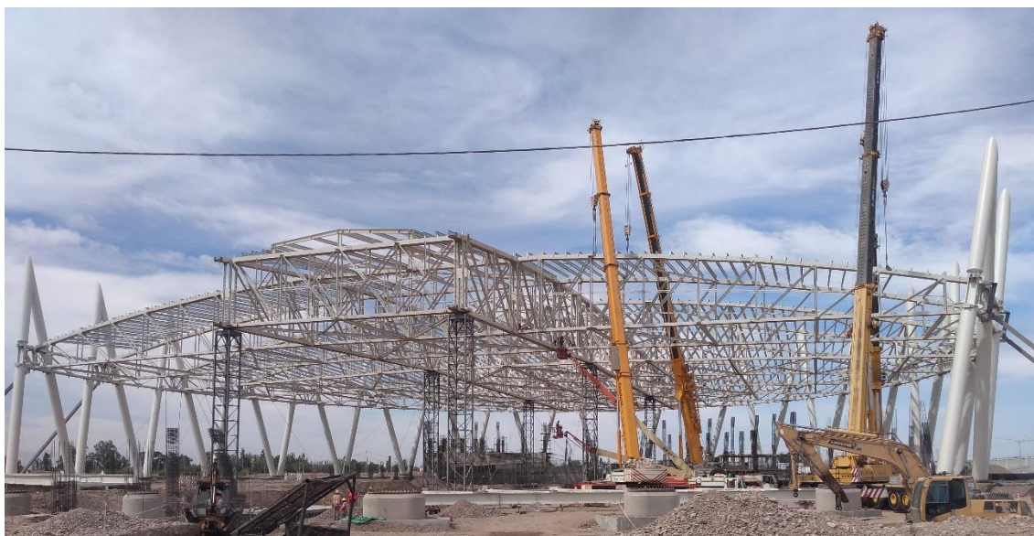
Figura 25. Montaje de módulo de cubierta lateral
