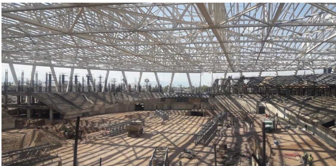
Figura 26. Estructura de la cubierta una vez finalizado el montaje y la remoción de las torres de montaje
